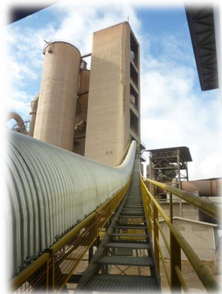
Es en la nave de combustibles alternativos donde se almacenan la biomasa, los combustibles alternativos procedentes de la trituración de los neumáticos y los CDR. Desde allí, son conducidos a los puntos de alimentación en el intercambiador o en el quemador principal. Además, se emplea gasóleo durante los procesos de arranque y calentamiento del horno.
